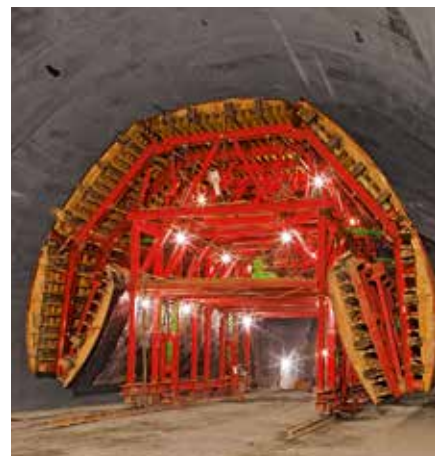
ソチ冬季オリンピック時建設パイパストネル
