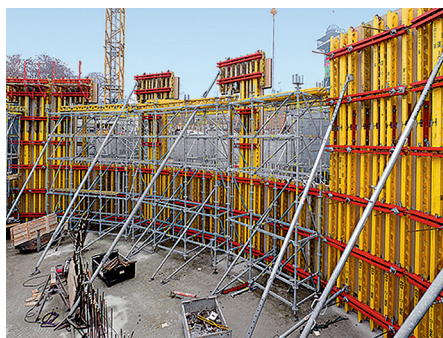
バリオ壁型枠との併用例 北極リング建設工事 コペンハーゲン動物園 デンマーク王国
