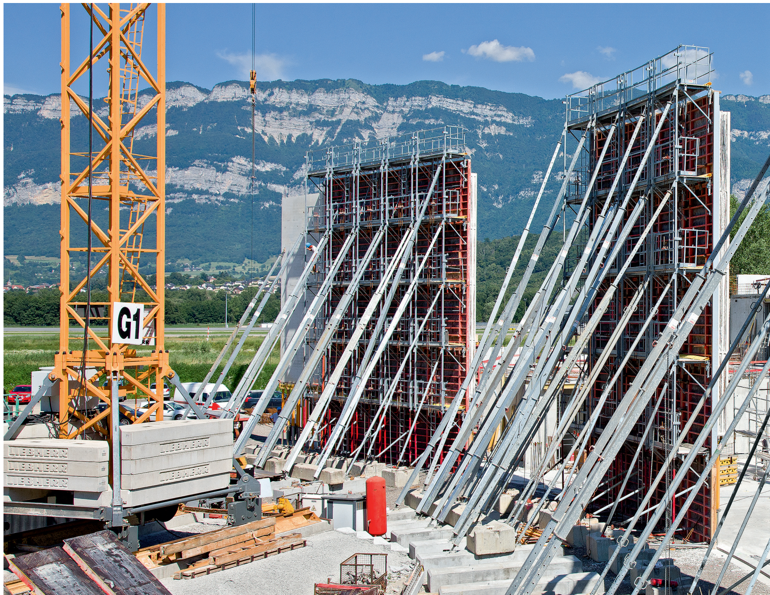
バリオGT24桁壁型枠との併用例 橋脚工事 VUZ研究所のヴェリム鉄道試験施設内 チェコ共和国
