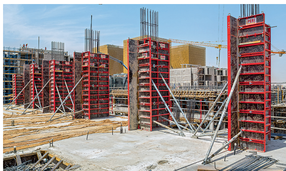
LICO柱型枠との併用 ITCCフェーズII リヤド、サウジアラビア王国
