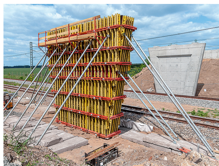
バリオGT24桁壁型枠との併用例 橋脚工事 VUZ研究所のヴェリム鉄道試験施設内 チェコ共和国
